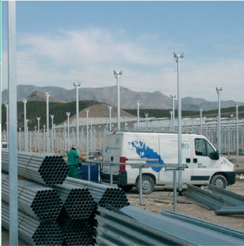
construcción de invernaderos greenhouse assembly
